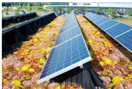
Afbeelding 2.3.16 - groendak in combinatie met PV panelen.
